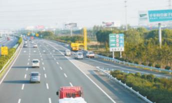
日前，市交通质监站组织对沪宁高速常州段青龙互通工程进行了竣工验收鉴定外业检查，并针对检查出的问题，要求建设单位组织整改。青龙互通式立交交叉为单喇叭+半定向匝道型，工程实施范围为沪宁高速公路喇叭+互通主体工程部分，包括沪宁高速拓宽、5个匝道的路基、桥涵、路面工程等施工，该项目于2014年9月24日通过交工验收。胡朝青供稿
